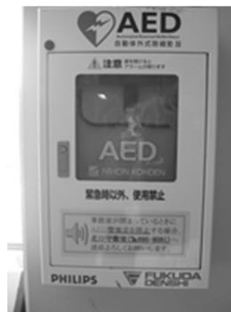
図Ⅱ. 2. 3 AED (工学部1号館事務室前)
