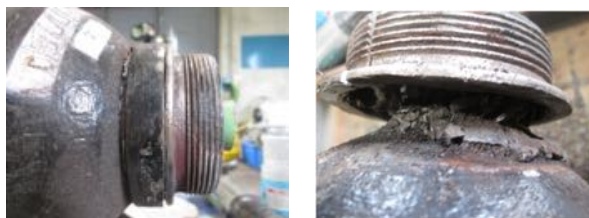
図 I. 3. 1 内部腐食の事例
