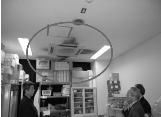
図Ⅲ. 1. 23 カビによる天井汚染と湯沸器の点検記録簿掲示
